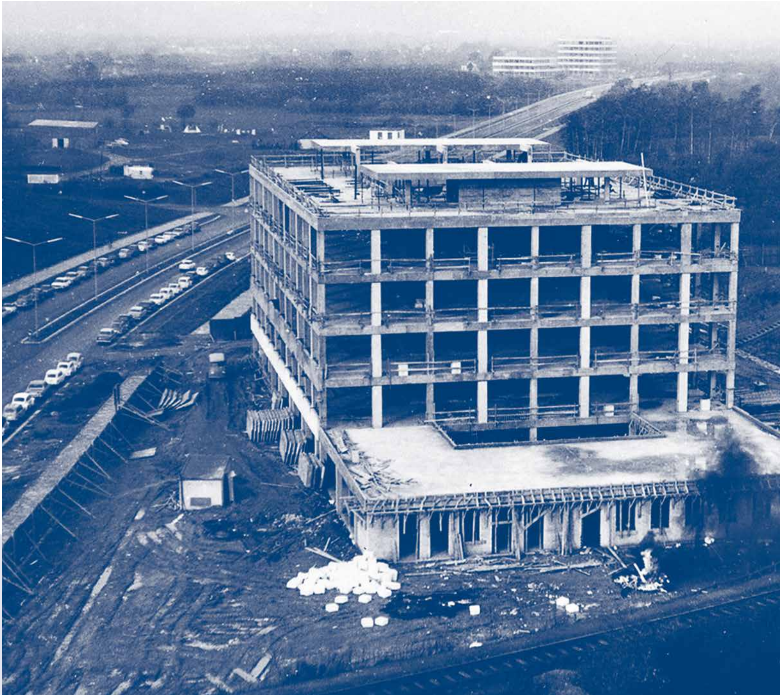
Das IPN-Gebäude im Bau um 1969.
